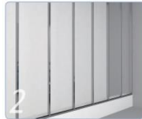
2. C-STUD를 600mm이내 간격으로 상·하부RUNNER 사이에 수직으로 설치
